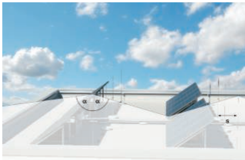
\alpha^\circ = Kąt ochronny, s = Odstęp separacyjny
