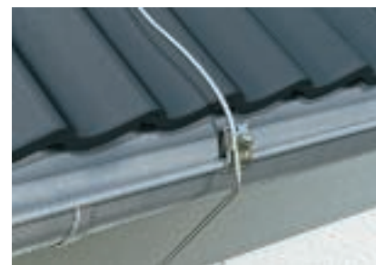
Przewód przymocowany zaciskiem rynnowym
